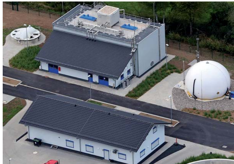
Bild 14: Kompaktfaulbehälteranlage auf der Kläranlage Westerbург für eine Anschlussgröße von ca. 30.000 E
